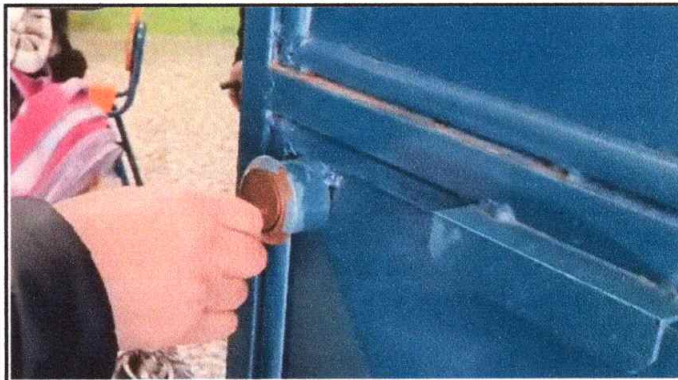
Foto 2: SUSTITUCIÓN DE CHAPA YALE ORIGINAL.
