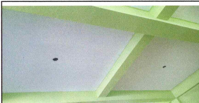
Foto 9: SUSTITUCIÓN DE PLAFONERAS MARCA BTICINO.
