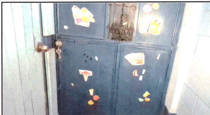
Foto 1: SUSTITUCION DE PUERTAS DE METAL.
